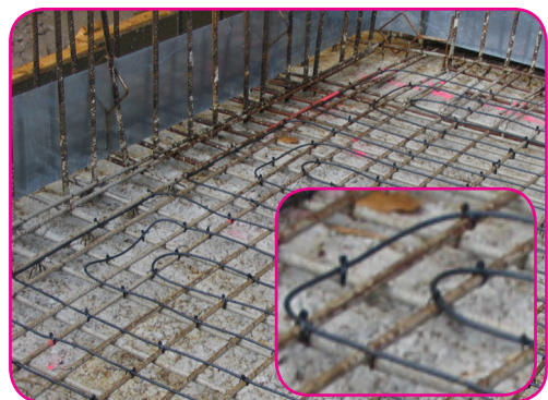
Verwarmingskabel gemonteerd op bouwstaalnet
